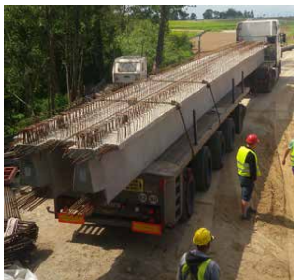
Rys. 56. Belki strunobetonowe typu T21 i T-27 – prefabrykaty na wiadukty w ciągu budowanej drogi ekspresowej S8 na odcinku od węzła „Marki” do węzła „Radzymin Płd” (ponad 700 belek)
