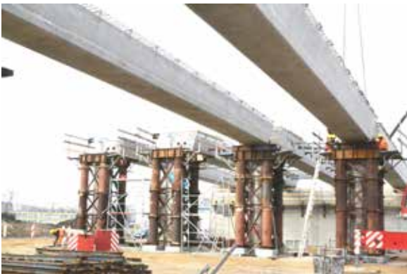
Rys. 15. Montaż belek strunowo-kablowych na tymczasowych podporach
