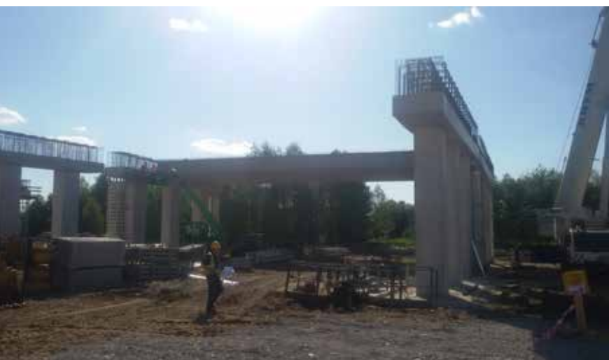
Rys. 56. Belki strunobetonowe typu T21 i T-27 – prefabrykaty na wiadukty w ciągu budowanej drogi ekspresowej S8 na odcinku od węzła „Marki” do węzła „Radzymin Płd” (ponad 700 belek)
