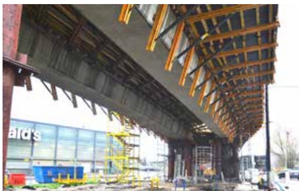
Rys. 18. Konstrukcja podszalunkowa przy zastosowaniu prefabrykowanych belek (a) i dla porównania przęseł monolitycznych (b)
