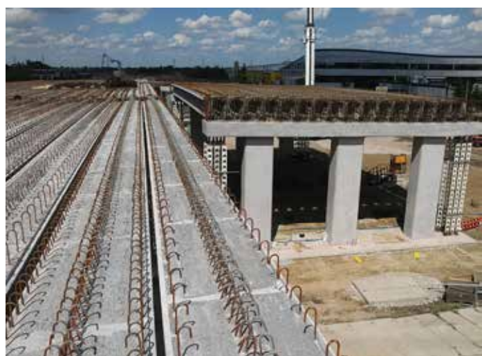
Rys. 56. Belki strunobetonowe typu T21 i T-27 – prefabrykaty na wiadukty w ciągu budowanej drogi ekspresowej S8 na odcinku od węzła „Marki” do węzła „Radzymin Płd” (ponad 700 belek)
