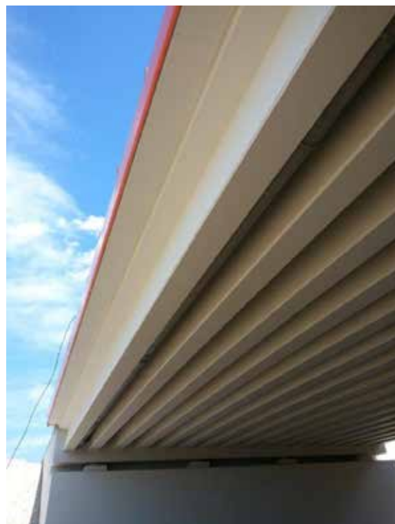
Rys. 63. Most w ciągu projektowanej drogi S-7 w gminie Orońsko
