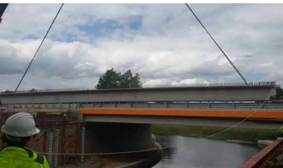
Rys. 56. Belki strunobetonowe typu T21 i T-27 – prefabrykaty na wiadukty w ciągu budowanej drogi ekspresowej S8 na odcinku od węzła „Marki” do węzła „Radzymin Płd” (ponad 700 belek)
