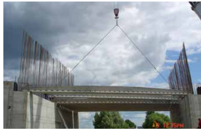
Rys. 58. Indywidualnie zaprojektowane przepusty żelbetowe wyprodukowane na potrzeby budowanej drogi ekspresowej S51 na odcinku Olsztyn-Olsztynek (ciężar ponad 40 T, rozpiętość 12 m)
