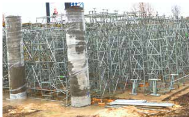
Rys. 18. Konstrukcja podszalunkowa przy zastosowaniu prefabrykowanych belek (a) i dla porównania przęseł monolitycznych (b)
