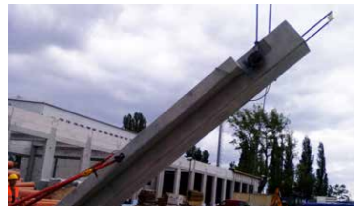
Fot. 11. Żelbetowy stupa prefabrykowany podnoszony przy pomocy sprzętu do transportu pionowego
