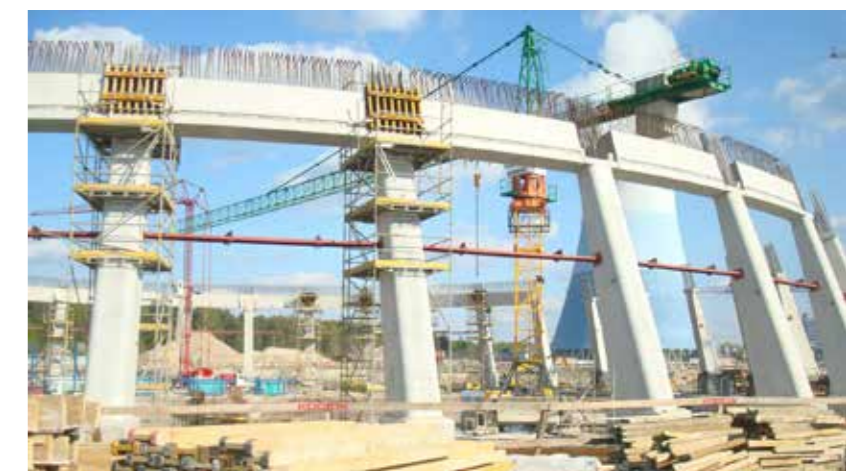
Fot. 27. Konstrukcja wsporcza chłodni kominowej
