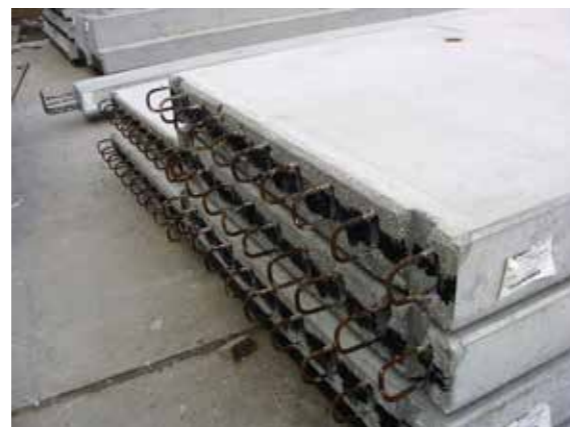
Rys. 34. Oparcie płyty spocznikowej na wsporniku stalowym (a), Płyta stropowa - widoczne otwory na pręty kotwiące (b), Płyta stropowa-pętla krawędziowe do zakotwienia w wieńcu (c)
