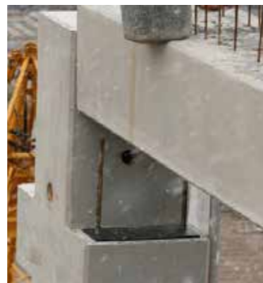
Rys. 25. Oparcie dźwigarów na słupie i podciągu: a) Oparcie z podcięciem dźwigara, b) Oparcie w „widłach”, c) Oparcie w gnieździe belki, d) Oparcie na konsoli w belce - 1. Podkładka elastomerowa, 2. Pręt żebrowany, 3. Rura karbowana, 4. Pręt wkręcany, 5. Podcięcie w dźwigarze, 6. Pręty nagwintowane z podkładką i nakrętką
