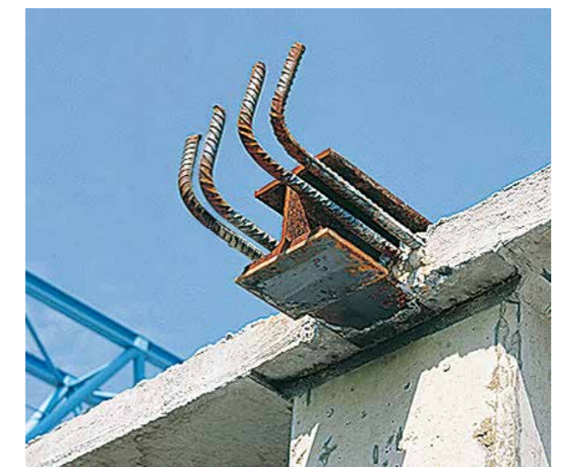
Rys. 32. Redukcja skręcania belki (a), podkład stalowy przed zabetonowaniem elementu (b), płyta TT z podkładem stalowym przygotowana do montażu (c)
