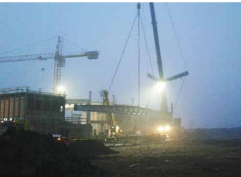
Fot. 9. Montaż dźwigara strunobetonowego
