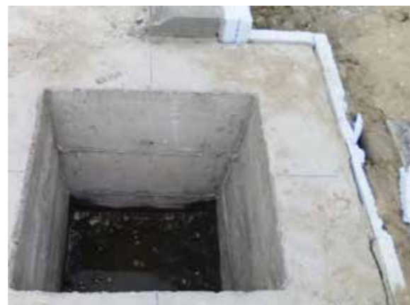
Fot. 10. Kielichowa stopa fundamentowa z naniesionymi osiami konstrukcyjnymi obiektu przygotowana do montażu żelbetowych stupów prefabrykowanych
