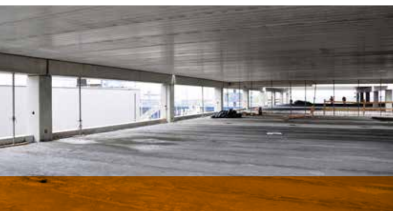
Fot. 17. Nocny montaż płyt stropowych TT (a) oraz parking nad peronami – stan surowy. Stropy kanałowe HC 500 o rozpiętości 16,45 m (b)
