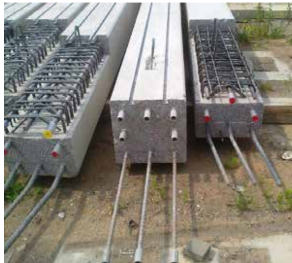
Fot. 2. Belki przewidziane do uciąglenia – widoczne zbrojenie do połączeń gwintowanych, uszorstniona powierzchnia czołowa do zespolenia z monolitem i odstąpienie części zbrojenia w celu dotożenia części prętów uciągających.
