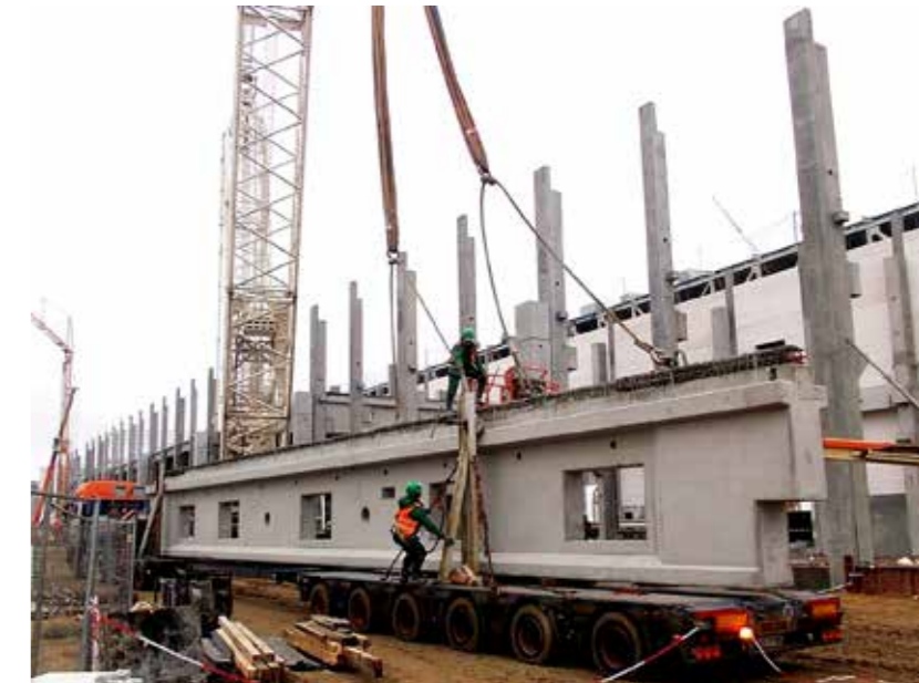
Fot. 15. Dźwigar stropowy pod duże obciążenia (Spine). Obniżona górna półka służy jako oparcie żeber płyt TT, wypuszczone zbrojenie – do zmonolityzowania z nadbetonem stropu
