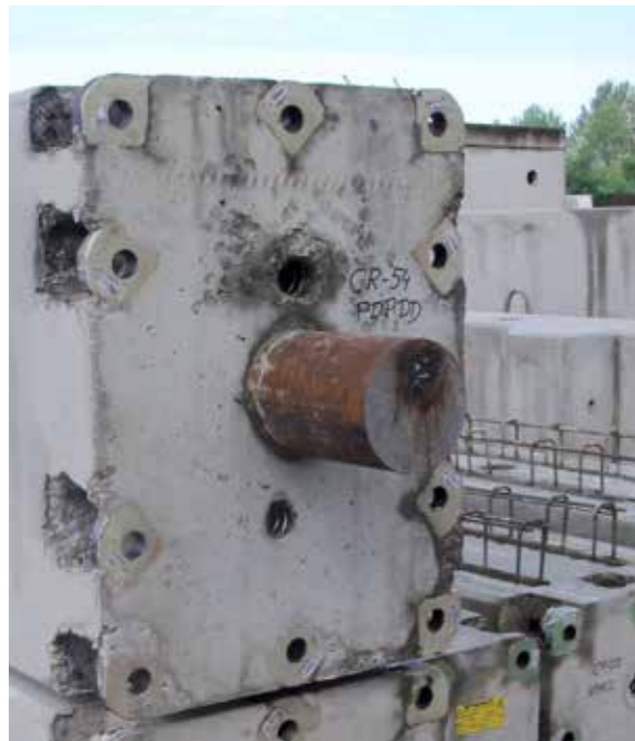
Fot. 16. Stupy montowane na łączniki słupowe skręcane, z przeniesieniem sił poziomych (od uderzenia) wbetonowanym trzpieniem stalowym
