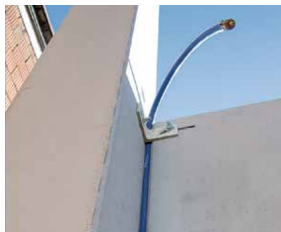
Rys. 41. Możliwe kierunki przenoszenia sił przez system pętli linowych (a), złącze stupa i ściany w systemie VS-ISI (b), połączenie ściany i stupa z widocznym przewodem ciśnieniowym uszczelniającym złącze (c)
