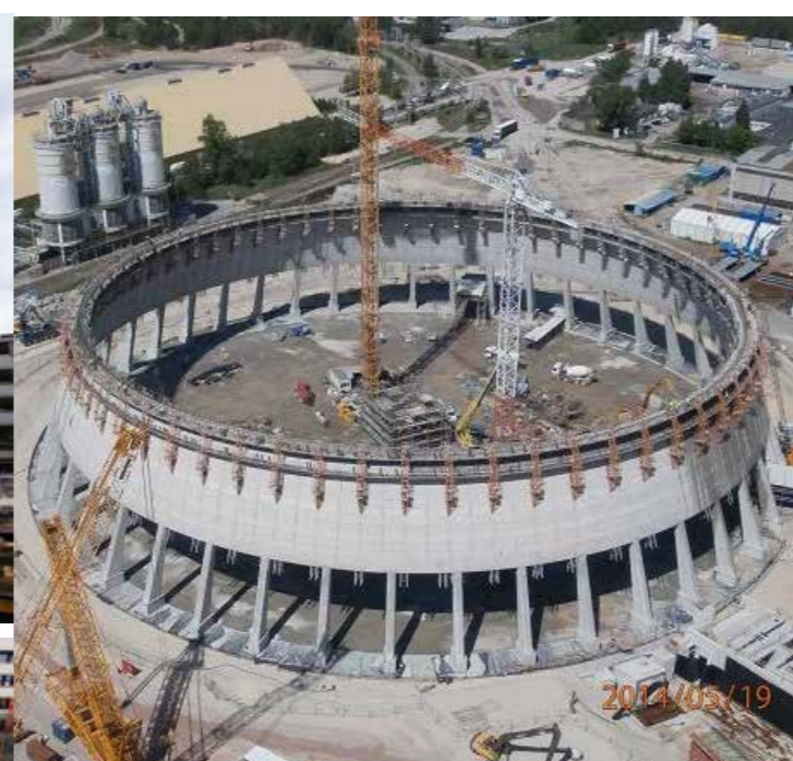
Fot. 26. Budowa cienkościennego płaszcza chłodni na prefabrykowanej konstrukcji wsporczej
