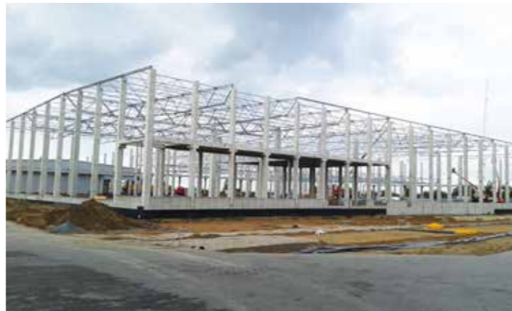
Fot. 16. Stupy montowane na łączniki słupowe skręcane, z przeniesieniem sił poziomych (od uderzenia) wbetonowanym trzpieniem stalowym
