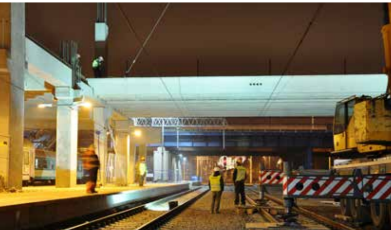
Fot. 17. Nocny montaż płyt stropowych TT (a) oraz parking nad peronami – stan surowy. Stropy kanałowe HC 500 o rozpiętości 16,45 m (b)
