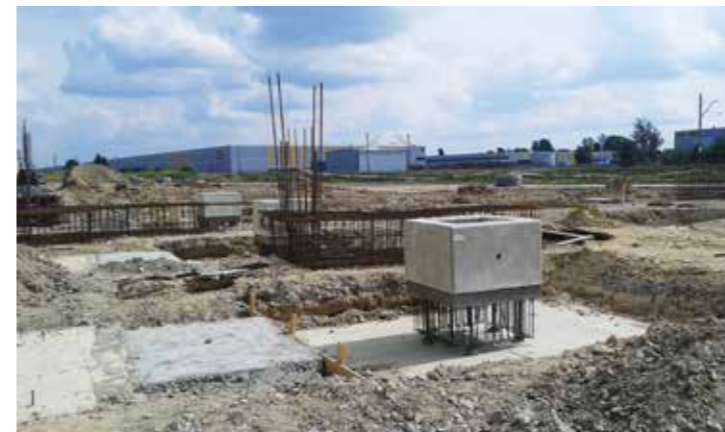
Fot. 8. Prefabrykowany kielich żelbetonowy usytuowany w miejscu trwałego zamocowania
