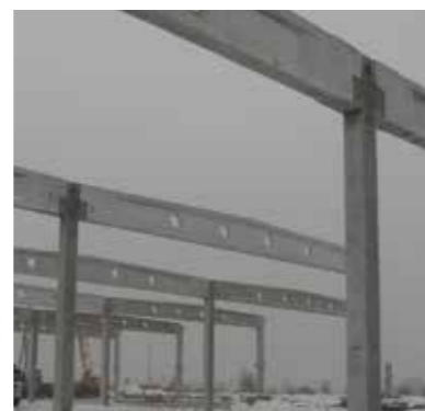
Fot. 32. Budowa konstrukcji hali produkcyjnej w warunkach zimowych
