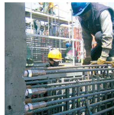
Fot. 1. System łączników zbrojeniowych (a), połączenie słupa prefabrykowanego z podciągiem (b)
