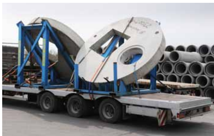
Rys. 17. Transport prefabrykatów wielkowymiarowych
