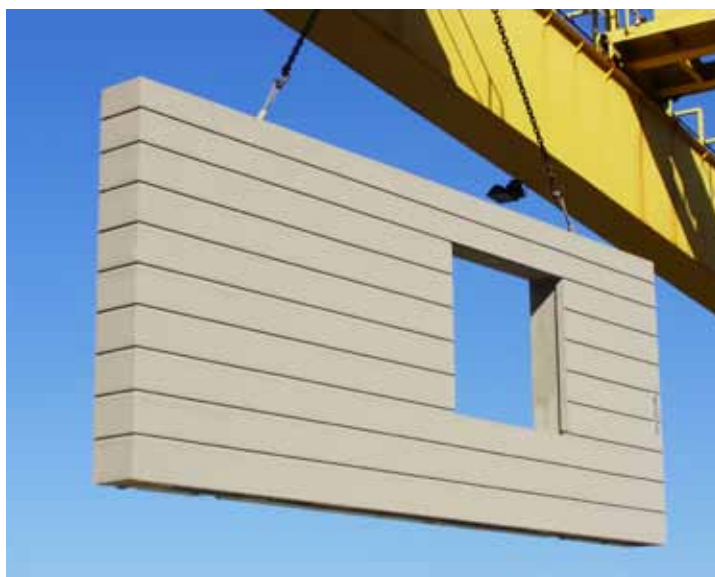
Rys. 53. Ściana 3-warstwowa z powierzchnią architektoniczną
