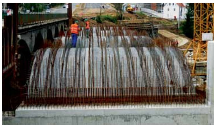
Rys. 59. Prefabrykowane łupiny mostu nad rzeką Bóbr w Jeleniej Górze
