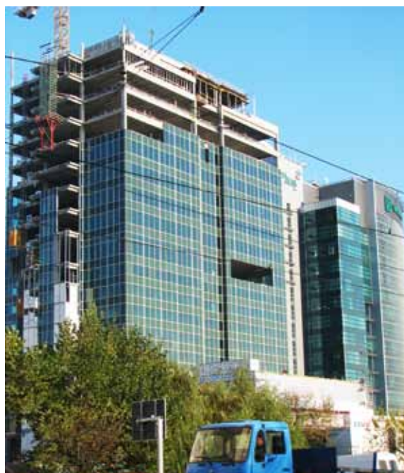
Rys. 39. Obiekty biurowe o konstrukcji szkieletowej
