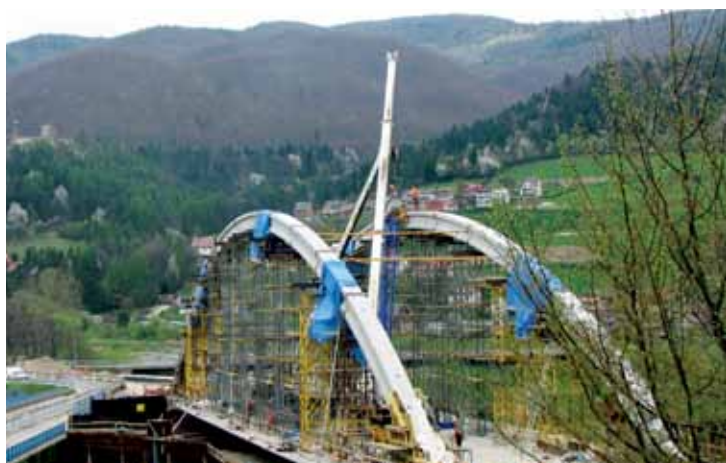
Rys. 58. Łuki prefabrykowane, poprzecznie przęsłowe – budowa wiaduktu nad linią PKP w miejscowości Rytno
