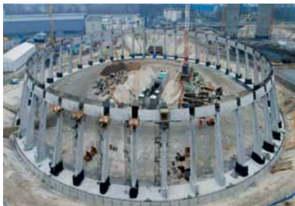
Rys. 66. Budowa chłodni kominowej
