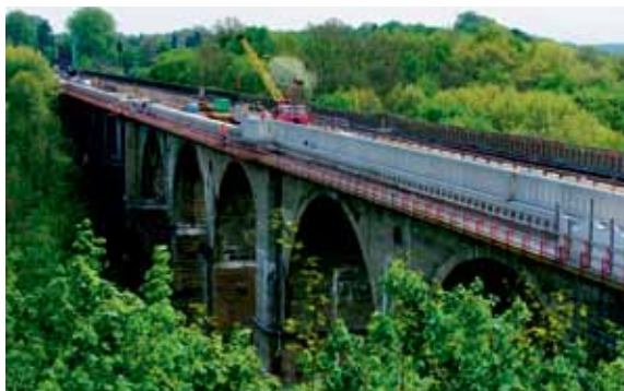
Rys. 61. Prefabrykaty gzymsowe wykonane w stylizowanych formach – most na Nysie Łużyckiej w Zgorzelcu
