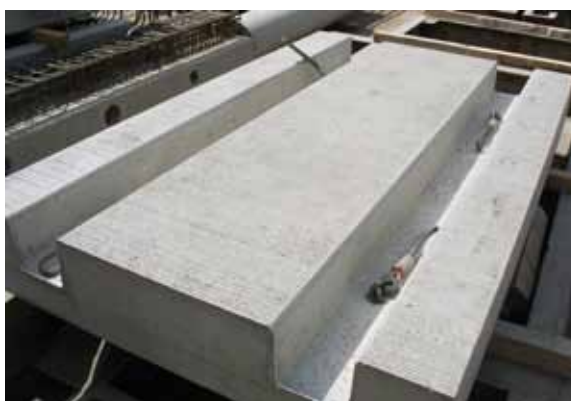
Rys. 61. Prefabrykaty gzymsowe wykonane w stylizowanych formach – most na Nysie Łużyckiej w Zgorzelcu
