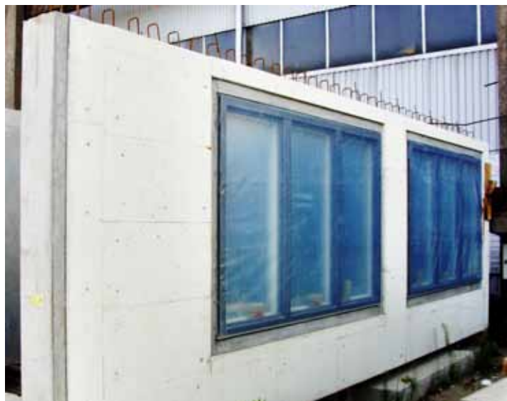
Rys. 52. Ściana 2-warstwowa z wbudowaną stolarką okienną
