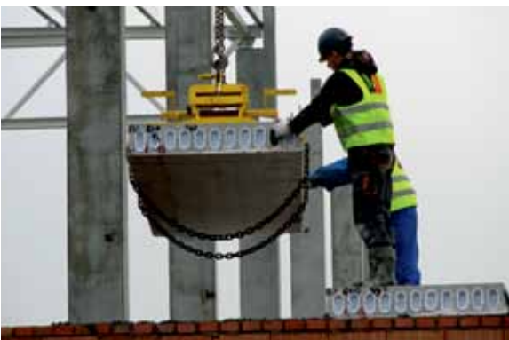
Rys. 45. Płyty kanalowe i ich montaż
