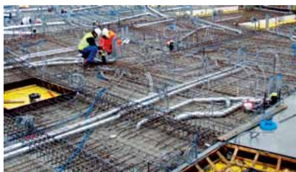
Rys. 54. Rozmieszczenie instalacji w nadbetonie stropu filigran
