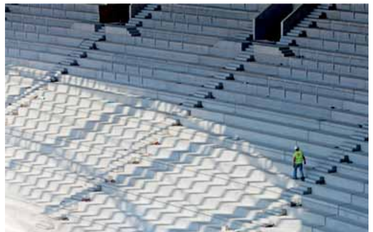
Rys. 29. Konstrukcja trybun z elementów prefabrykowanych
