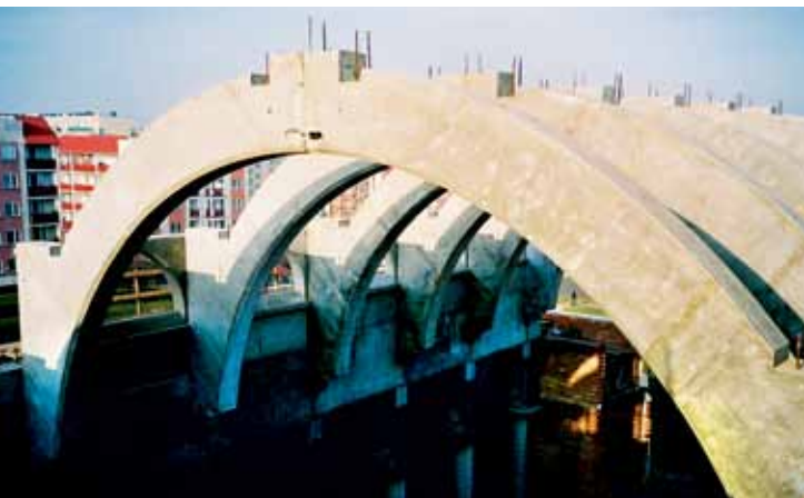
Rys. 69. Prefabrykowane dźwigary w konstrukcji kościoła
