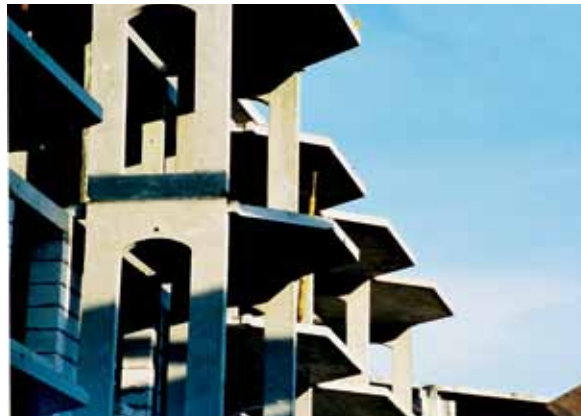
Rys. 36. Prefabrykowane elementy ścienne oraz balkonowe
