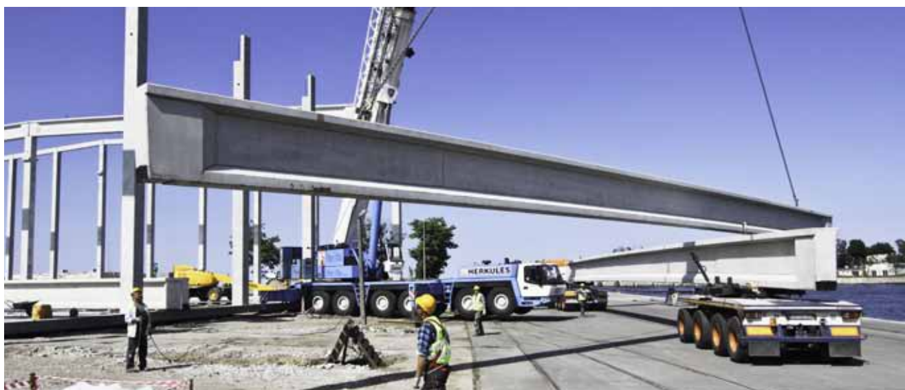
Rys. 17. Transport prefabrykatów wielkowymiarowych
