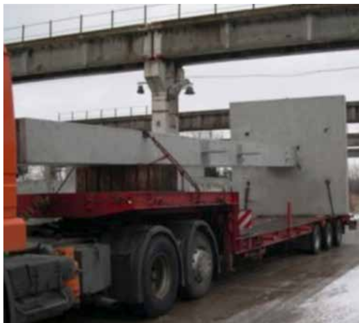
Fot. 28. Stopostup przygotowany do transportu (a) oraz element podczas montażu (b)
