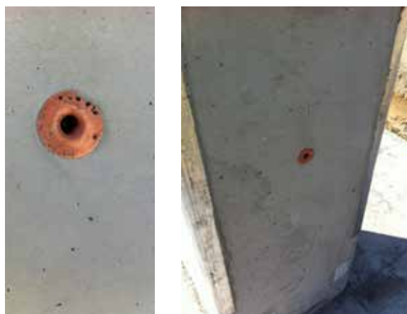
Fot. 13. Mufa miedziana przygotowana do przykręcenia instalacji odgromowej
