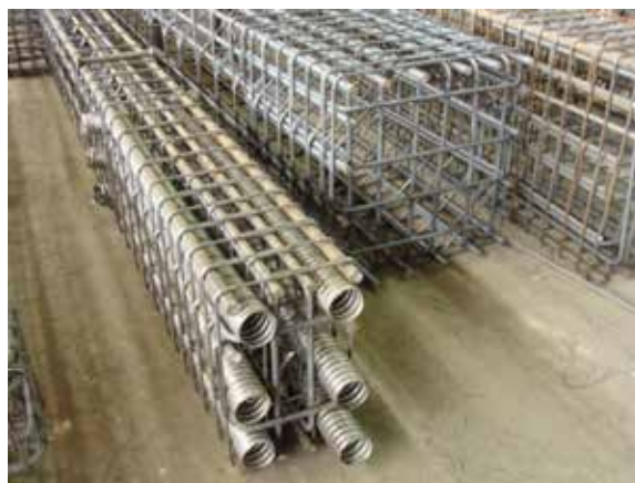
Fot. 12. Typowe zbrojenia słupów
