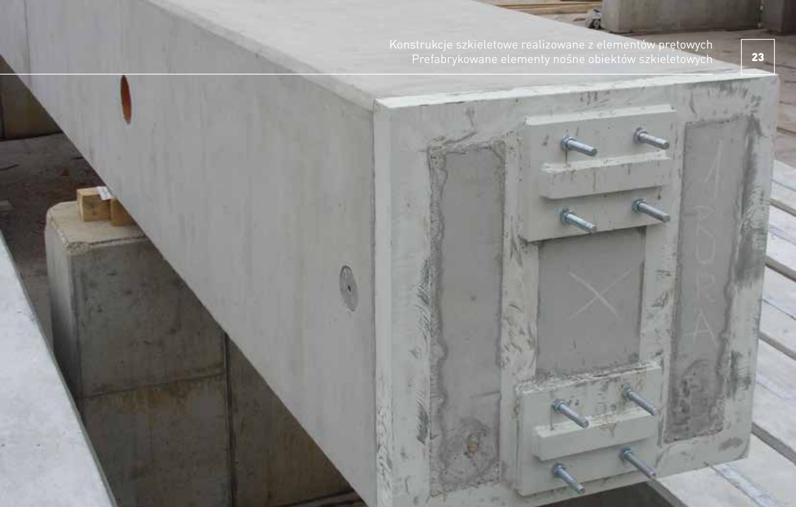
Fot. 10. Głowica słupa pod konstrukcję stalową. Na boku widoczny wypust instalacji odgromowej i otwór na trzpień montażowy
