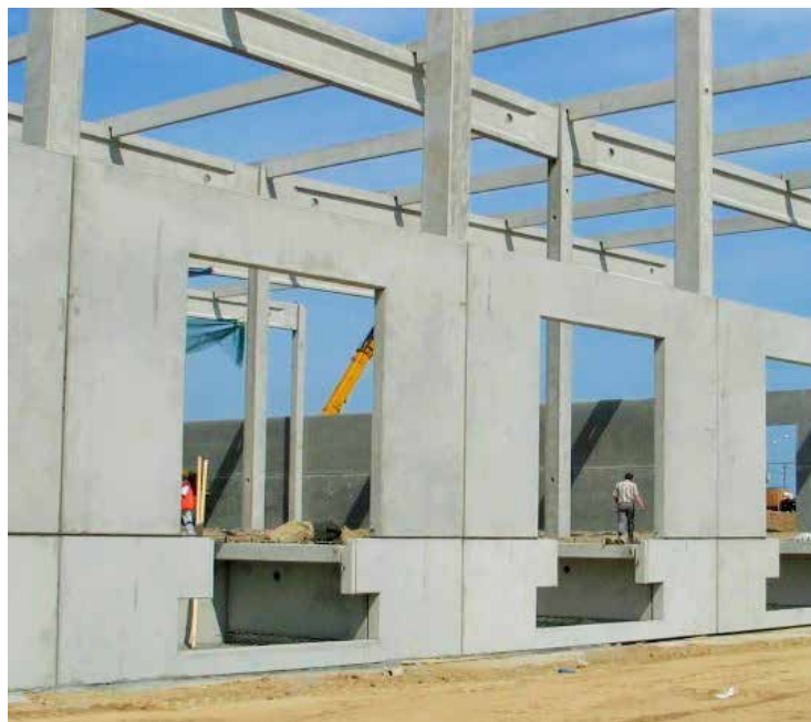
Fot. 23. Prefabrykowane ściany obudowy doków (również prefabrykowanych w formie przestrzennych skrzyń)
