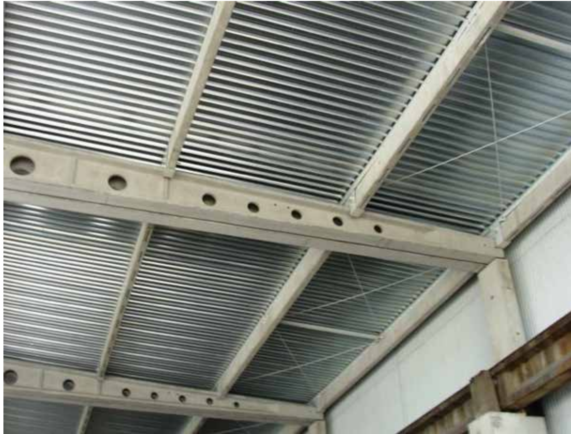
Fot. 3. Konstrukcja dachu płatwiowego z pokryciem blachą trapezową. Widoczne stężenia połaciowe
