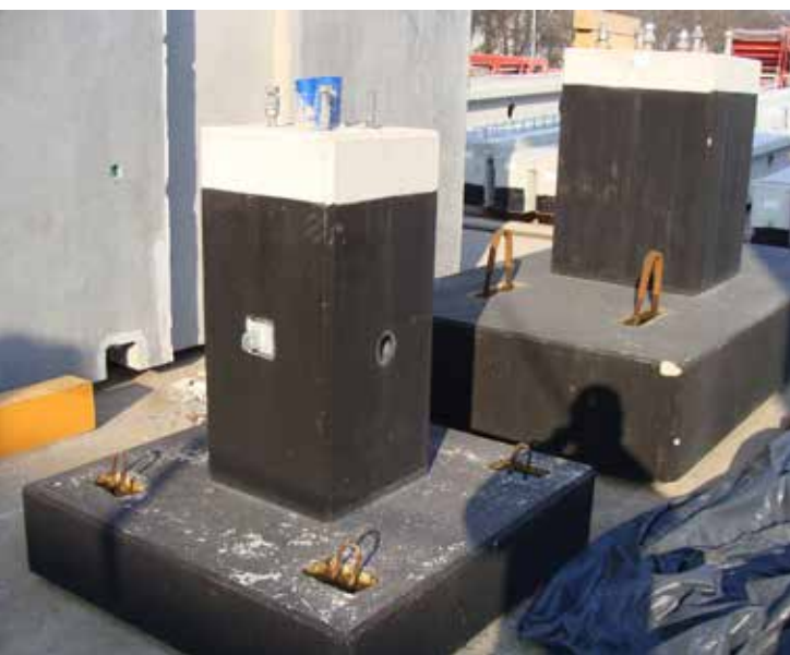
Fot. 27. Stopa pod słup stalowy
