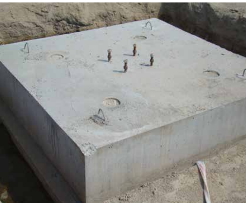
Fot. 26. Stopy fundamentowe mocowane za pomocą łączników systemowych
