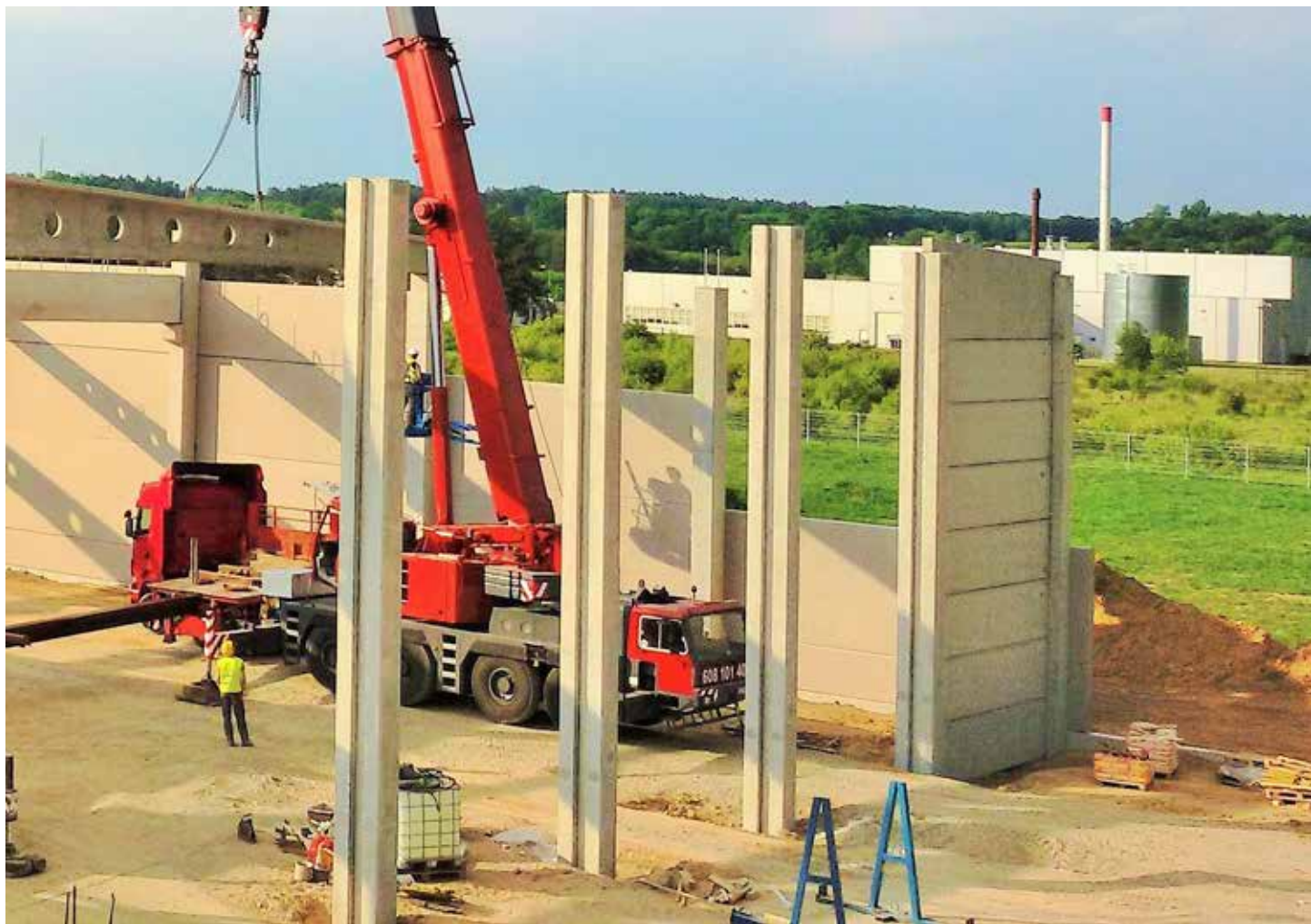
Fot. 21. Plan I – ściana oddzielenia pożarowego z płyt kanalowych WHC i słupów „H”. Plan II – zewnętrzna ściana ostonowa
