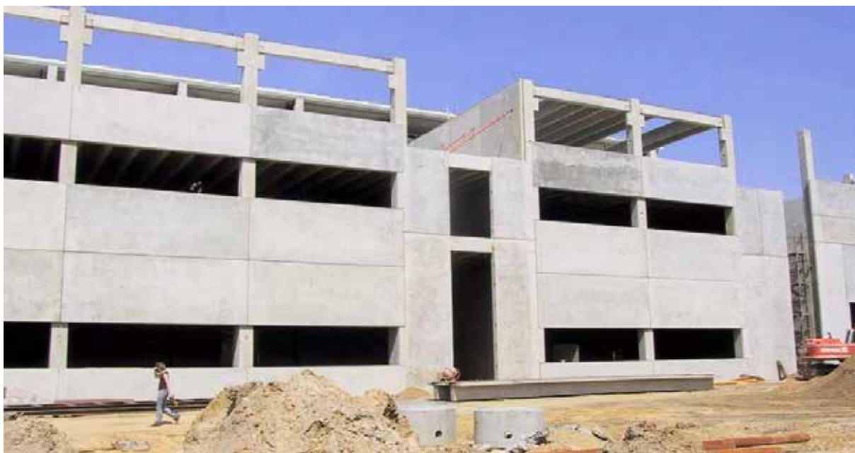
Fot. 20. Ściana zewnętrzna z płyt samo- nośnych i zawieszanych
