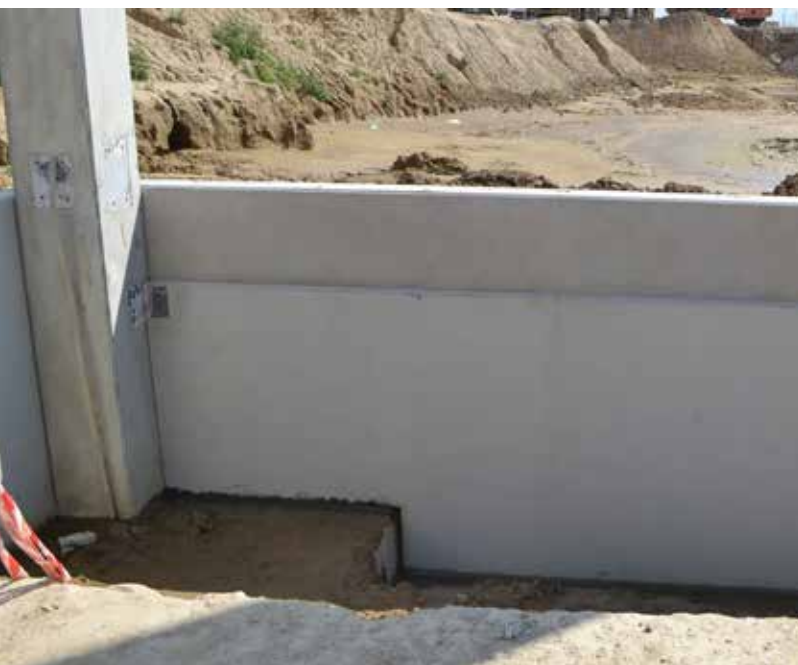
Fot. 22. Podwalina oparta na stopach i mocowana do stóp
