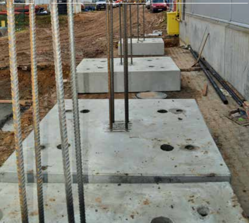
Fot. 25. Stopy prefabrykowane do łączenia na wytyki
